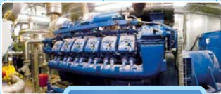
Generadors d'electricitat a partir del biogàs
